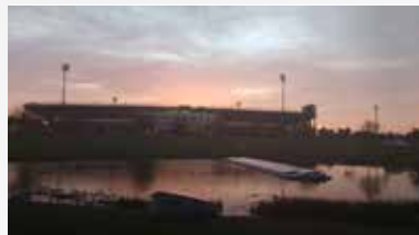
ORLANDO, USA - 5 kWp (extension 900 kWp)
